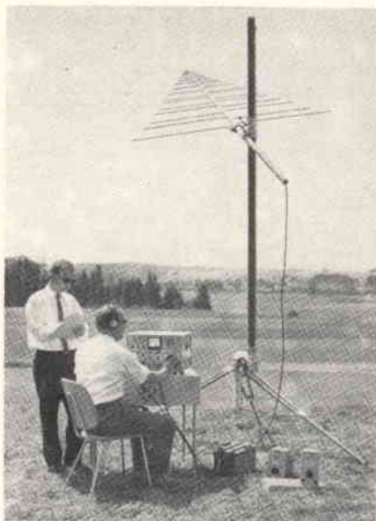
Fig. 6 - Misure di campo all'aperto su frequenze VHF-UHF mediante antenna log-periodica serie BN e misura-campo della Rohde & Schwarz.
